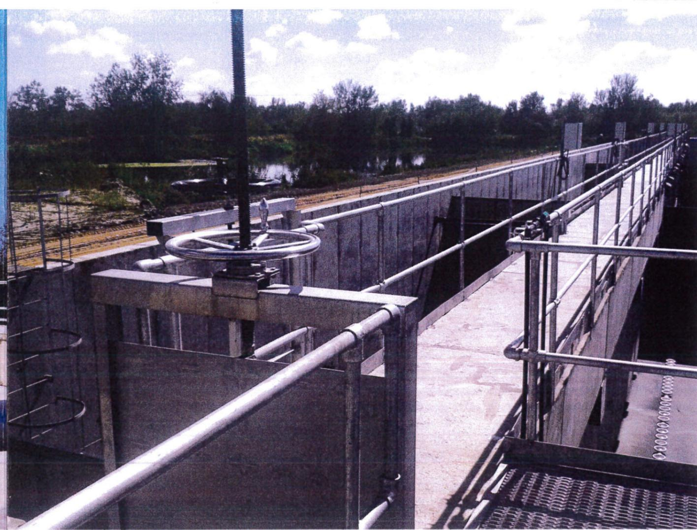
В соответствии с планом развития общегородских очистных сооружений канализации г. Бреста, в рамках проекта «Реконструкция городских очистных сооружений в г. Бресте (комплекс сооружений по удалению азота и фосфора с автоматизацией технологических процессов). I очередь. I пусковой комплекс» выполнены работы по строительству нового аэротенка и трансформаторной подстанции на канализационных очистных сооружениях.
