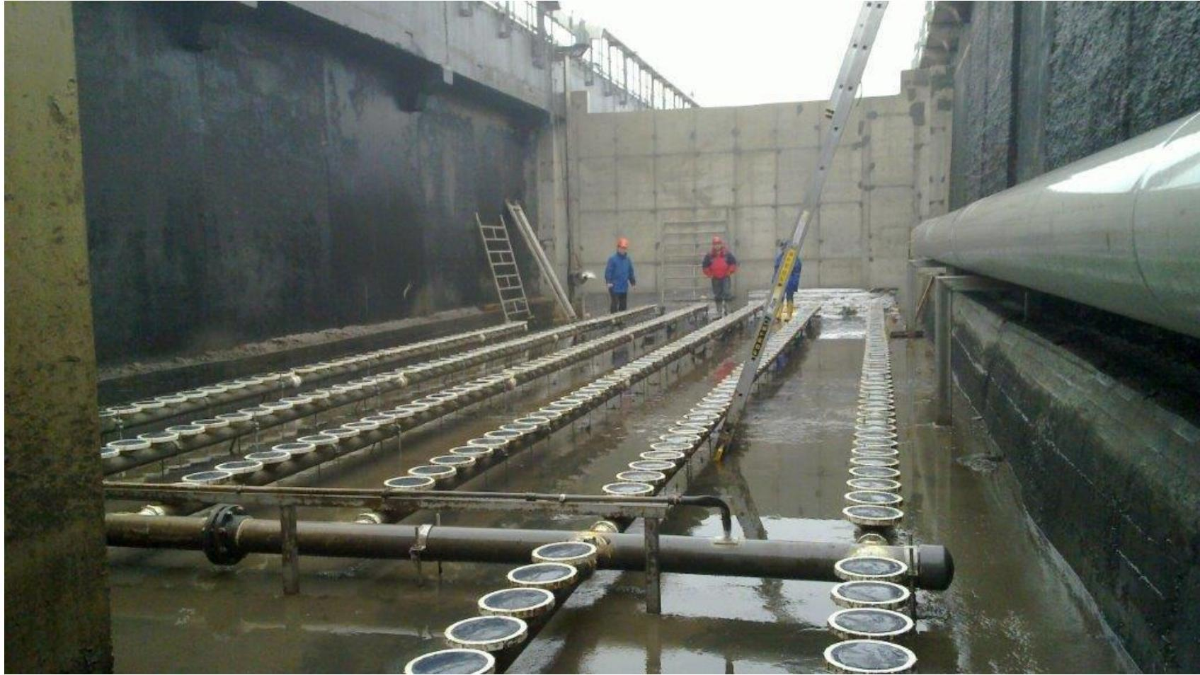
*Rekonstrukcija aeracionog rezervoara, instalacija membrane aeracionog sistema*
