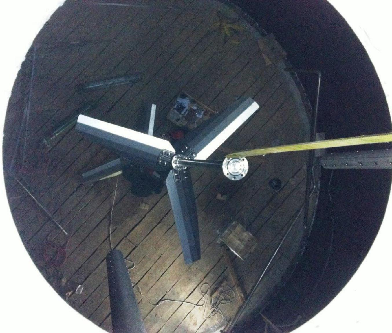
*Vertikalna instalacija za mešanje u digestoru*
