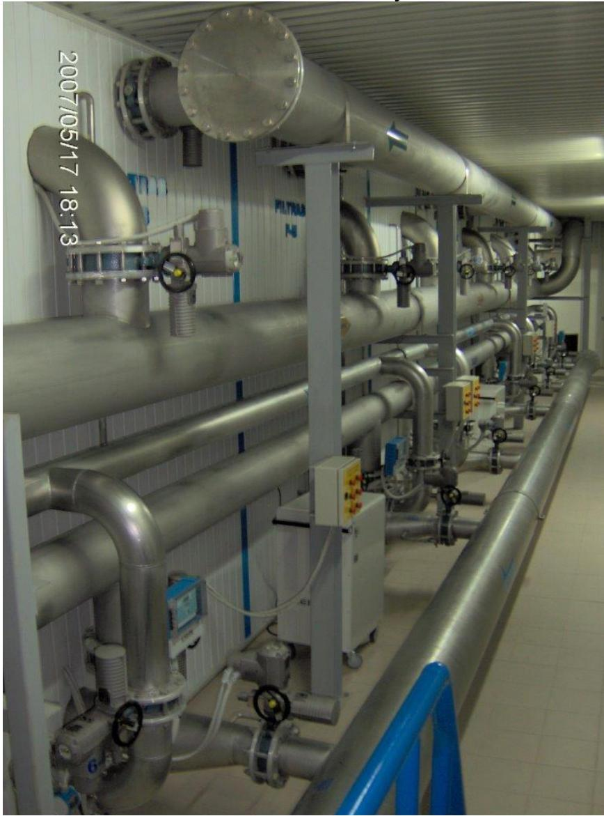
*Novi cevovodi sa automatskom regulacijom peščanih filtera*
